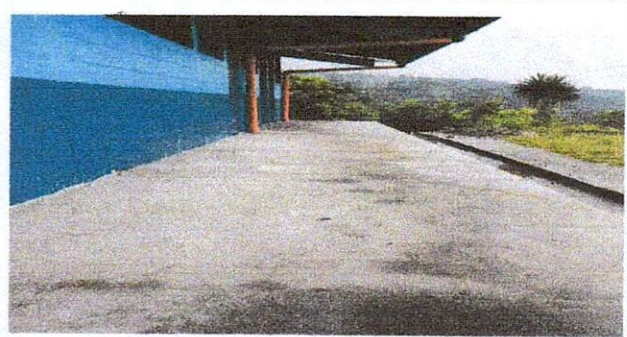
Foto 2: Piso de torta de cemento.
