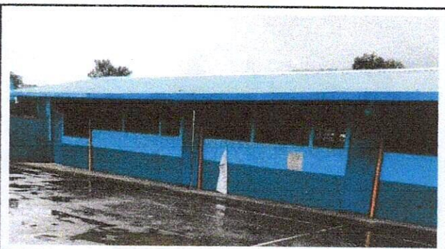
Foto 4: Pintura de muros exteriores e interiores de la escuela ya finalizada.
