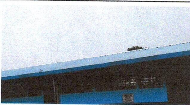
Foto 3: Canales de metal ya colocados.
